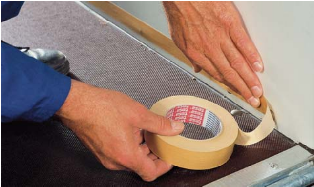
1. Abkleben der Seitenwände
