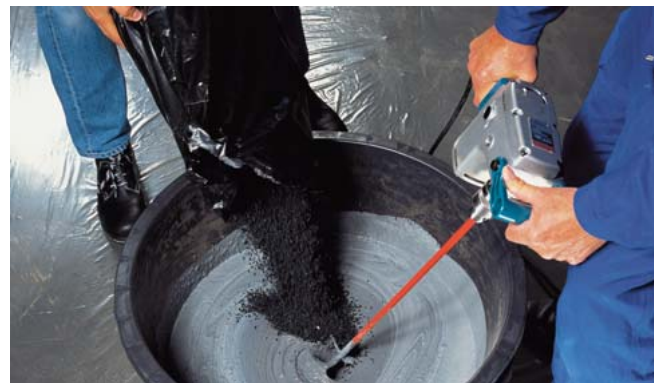
6. Gummigranulat unter ständigem Rühren komplett hinzufügen ...
