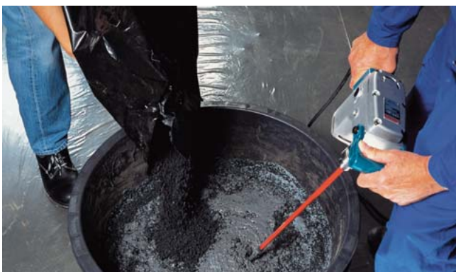
7. ... und zu einer einheitlichen Masse verrühren
