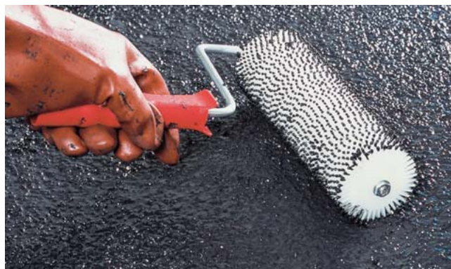
10. Mit der Spikerrolle leicht kreuzweise abrollen (ohne Druck, nur mit Eigen- gewicht der Rolle)
