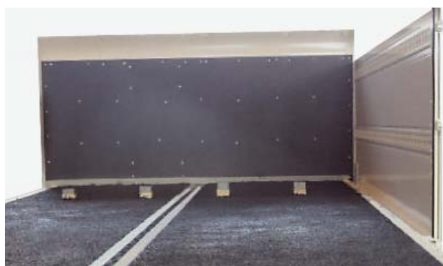
12. Boden drei bis fünf Tage aushärten lassen
