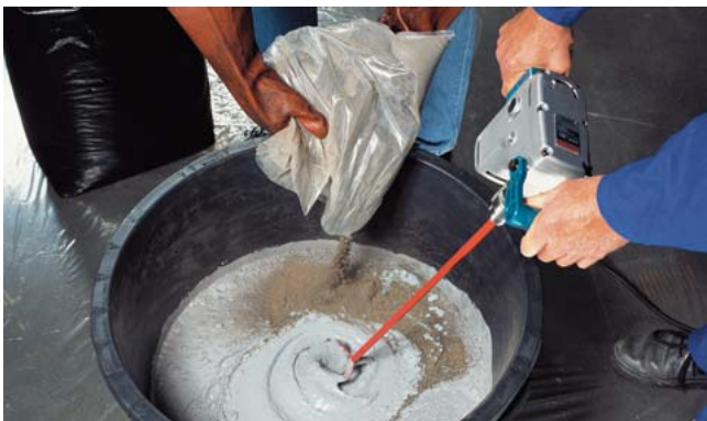
5. Härtepulver unter ständigem Rühren zügig beimischen
