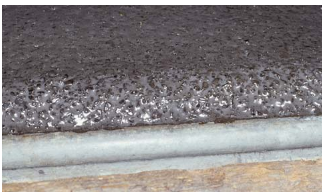
11. Am Heck leicht auslaufen lassen
