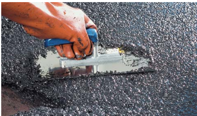
9. Gleichmäßig auseinander streichen, Unebenheiten regulieren. GETO Antislip soft kann direkt an die Seitenwände gezogen werden.
